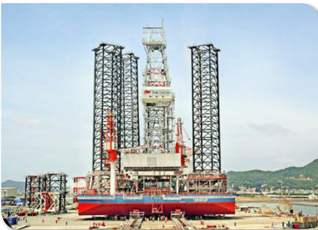
Giàn khoan tự nâng 90m nước là bước đột phá của ngành cơ khí dầu khí trong việc từng bước chế tạo, lắp ráp những sản phẩm cơ khí công nghệ cao. Ảnh: LV.
