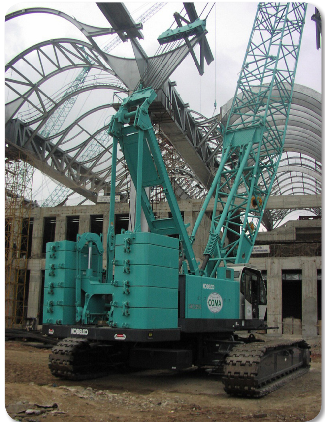
Sản phẩm kết cấu thép xây dựng của COMA được đưa vào ứng dụng trong nhiều công trình. Ảnh: LV.
