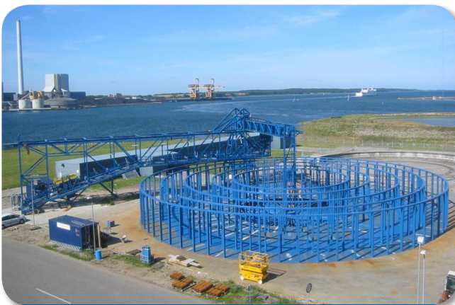
Bàn quay cuốn cáp cho hệ thống đường ống, một trong những sản phẩm của IMECO được đưa vào ứng dụng ở nhiều công trình. Ảnh: LV.
