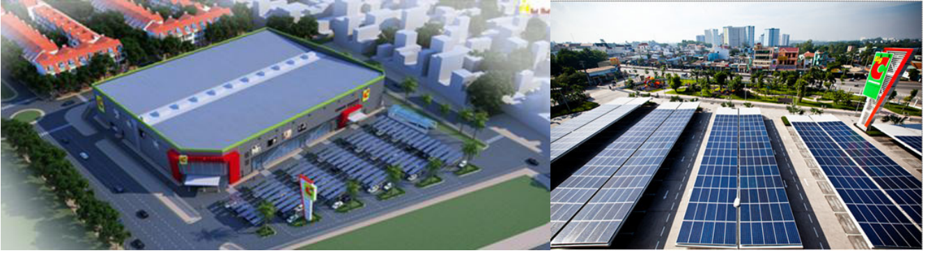
Hệ thống phát điện sử dụng NLMT trên mái che khu vực giữ ô tô, xe máy tại siêu thị Big C. Nguồn: Big C.
