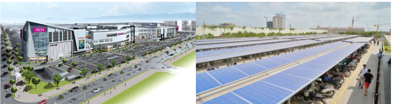
Hệ thống phát điện sử dụng NLMT trên mái che khu vực giữ ô tô, xe máy tại siêu thị Aeon. Nguồn: Aeon.
