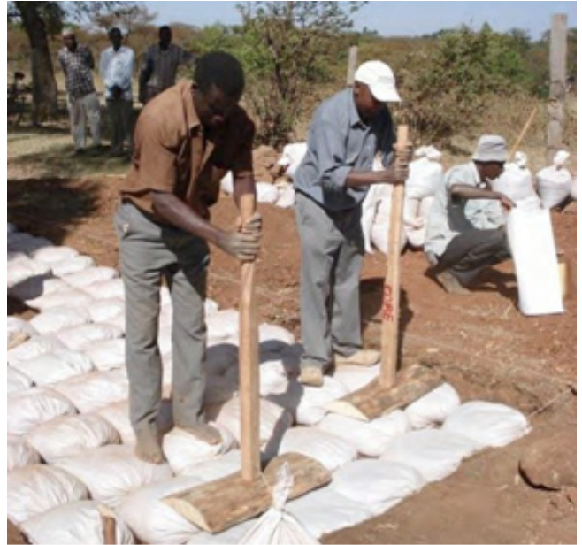
Bước 4: Xếp bao vào rãnh một cách có hệ thống sao cho miệng bao được lèn chặt phía dưới. Các bao cách nhau khoảng thích hợp. Bước kế tiếp là đầm chặt các bao (mỗi bao ít nhất 15 lần) cho đến khi độ dày mỗi bao còn khoảng 10 cm.
