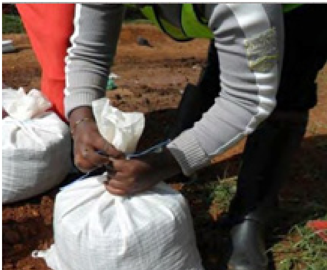
Bước 2: Đổ đất vào bao tải, buộc lại. Công đoạn buộc bao tải quan trọng, quyết định độ bền và sức chịu tải của bao sau khi đầm.
