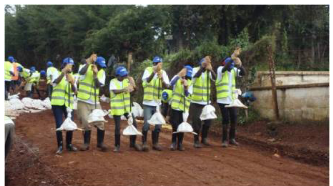
Bước 6: Sau khi lớp bao tải đất cuối cùng đã được đầm chặt, phủ 10 cm đá ong hoặc đá dăm lên bề mặt để hoàn thiện. Lớp này sẽ ngăn bao tải tiếp xúc trực tiếp với ánh nắng, chim chóc, xe cộ..., đảm bảo độ bền cho con đường.
