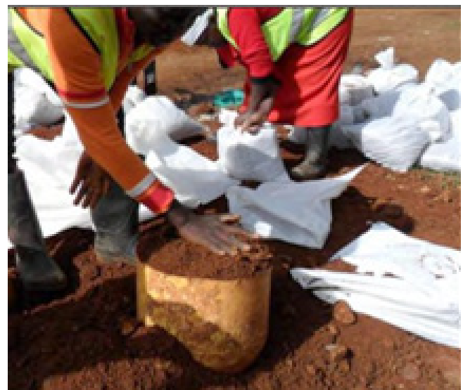
Bước 1: Dùng thùng đựng đất (hoặc vật liệu nhồi), khối lượng khoảng 20 - 25 kg tùy vật liệu sử dụng.
