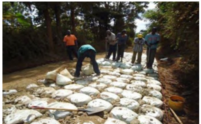
Bước 5: Đổ từ 1-3 lớp đất để lấp đầy khoảng hở giữa các bao đã đầm trước khi tiếp tục đặt thêm lớp bao tải khác lên trên.
