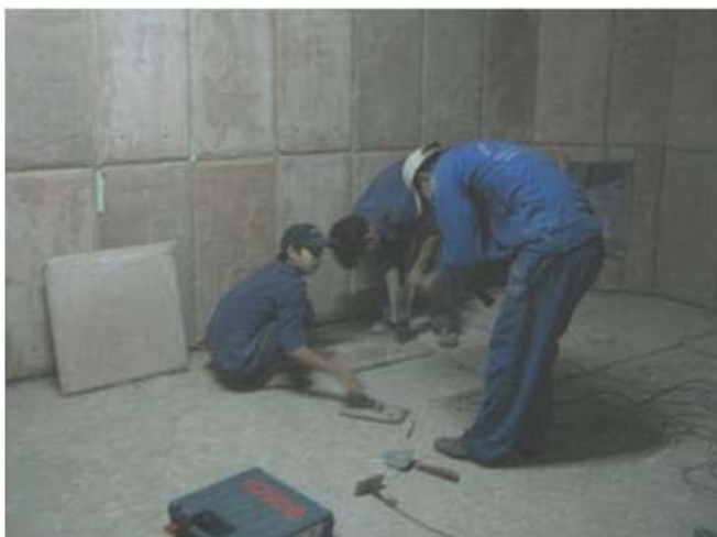
Lắp đặt tấm chắn chống phóng xạ cho phòng X quang bệnh viện 175
