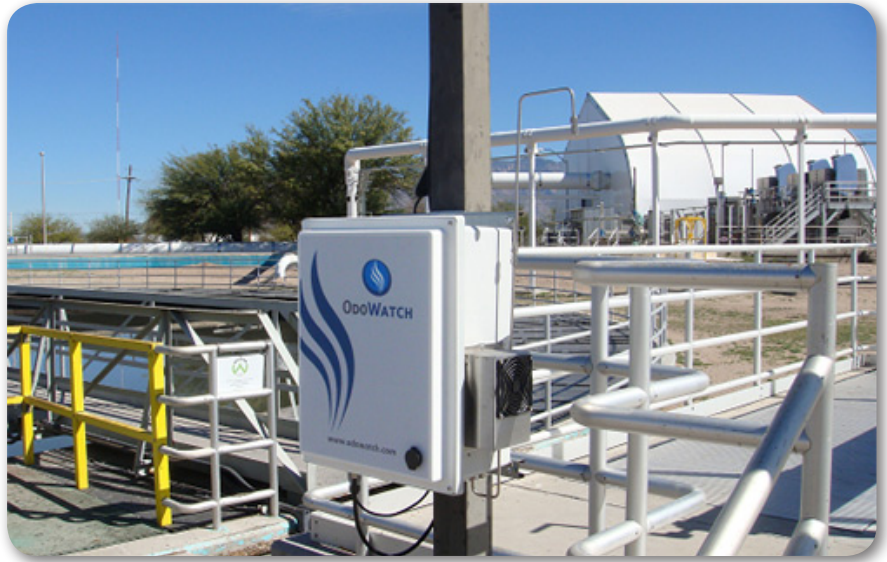
OdoWATCH - Thiết bị mũi điện tử của Công ty Veolia Water (Pháp) dùng để kiểm tra nguồn nước thải từ các nhà máy công nghiệp
