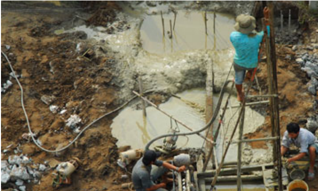
Cảnh khoan giếng nước ngầm tại TP.HCM
