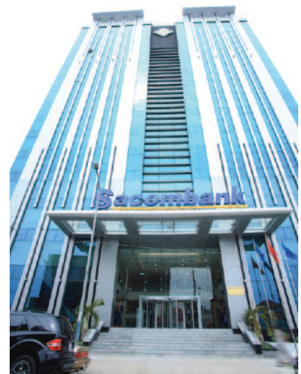
Tòa nhà trụ sở và trung tâm dữ liệu Sacombank – TP. HCM
